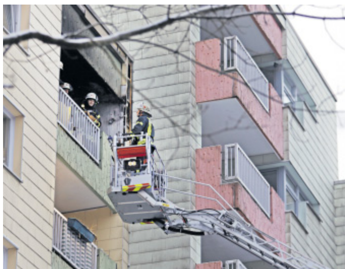
Maßarbeit: Die Drehleiter der Bielefelder Feuerwehr musste zwischen zwei Bäumen bewegt werden.
