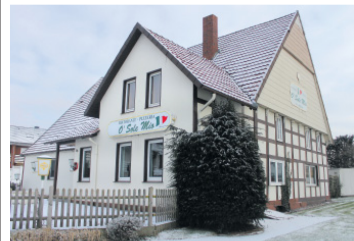
Bald Geschichte: Für das Gebäude, in dem früher ein italienisches Restaurant untergebracht war, besteht seit 2016 eine Abbruchgenehmigung.
